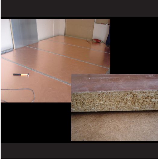
Resim 6. MR çekim odasının, cihaz kurulmadan önce kalkanlanması. Oda duvarları bakır-galvaniz plakalarla çevrelenmektedir. Plakalar, sunta üzerinde 0,5 mm kalınlıkta tabakalar halinde yerleştirilmiştir.
